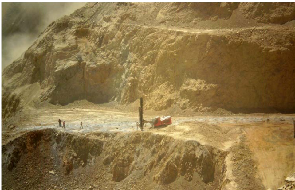
Perforadora realizando una grilla de barrenos
